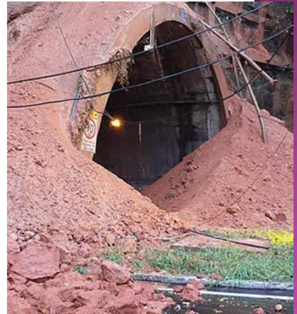
Deslizamentos de terra na Indonésia
